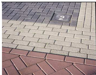
Figuur 2.3 Keiformaat betonstraatsteen Amsterdams Rood van Struyk Verwo Infra
