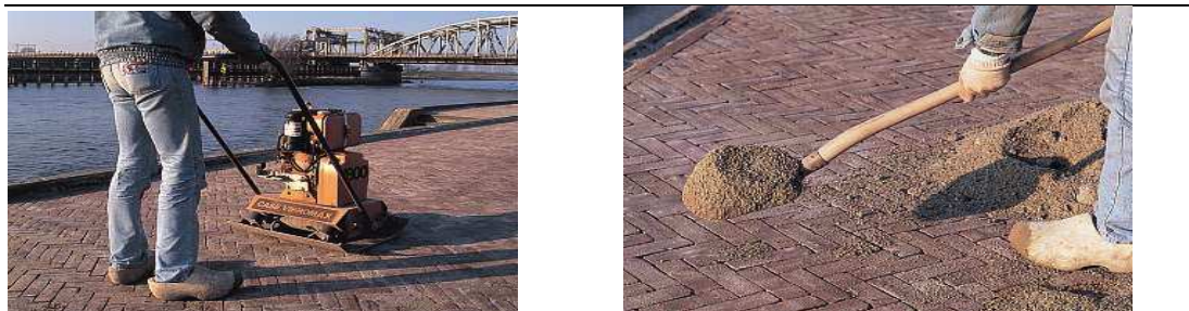
Figuur 2.15 Antrillen stenen en opbrengen voegzand
