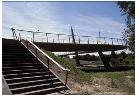
De fietsbrug te Emmen is tevens bereikbaar middels een kortsluitende trap met fietsgoot.
