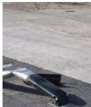
Installatie in Rigid (beton)
